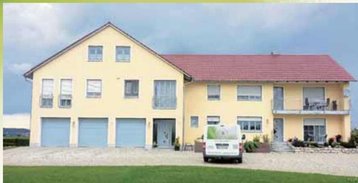
Anhand dieser Vorher-Nachher-Bilder lässt sich deutlich die Wirkung einer farblichen Fassadengestaltung erkennen. (Bild oben: vorher, Bild unten: nachher).
